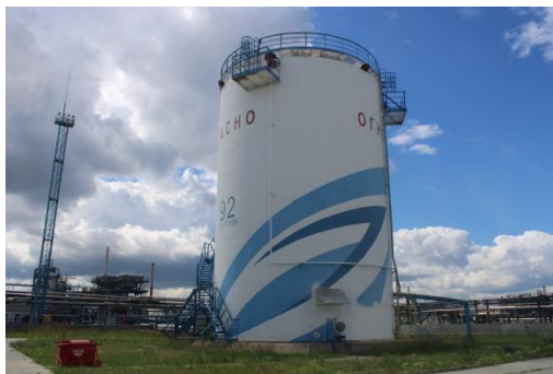
Рисунок 1 – Общий вид резервуара стального вертикального цилиндрического РВС-2000.
