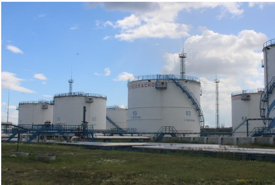
Рисунок 2 – Общий вид резервуаров стальных вертикальных цилиндрических РВС-5000.
