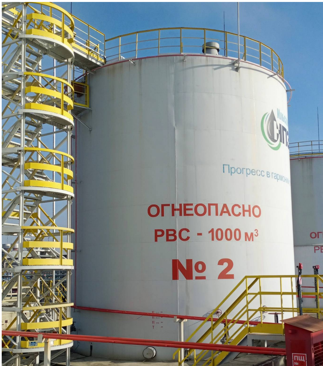
Рисунок 2 - Фотография общего вида резервуара РВС-1000 заводской номер 2.
