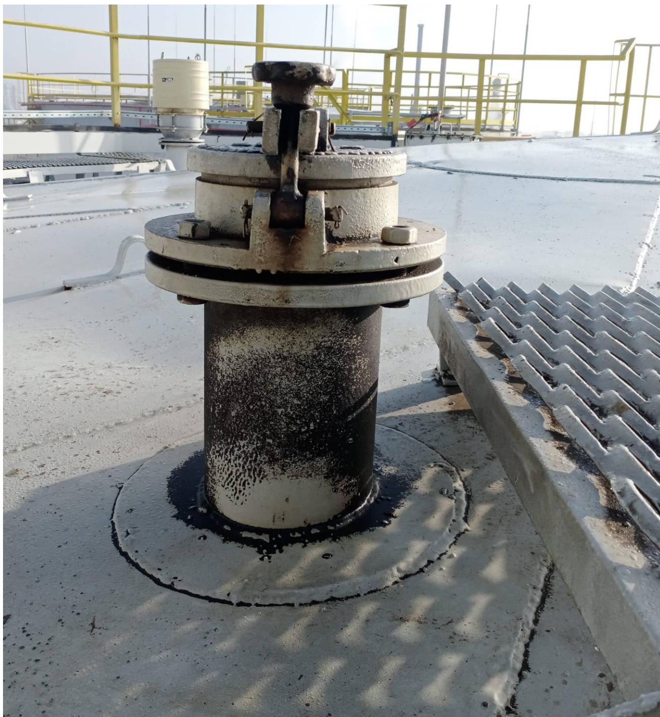
Рисунок 4 - Фотография горловины замерного люка резервуара РВС-1000 заводской номер 2.
