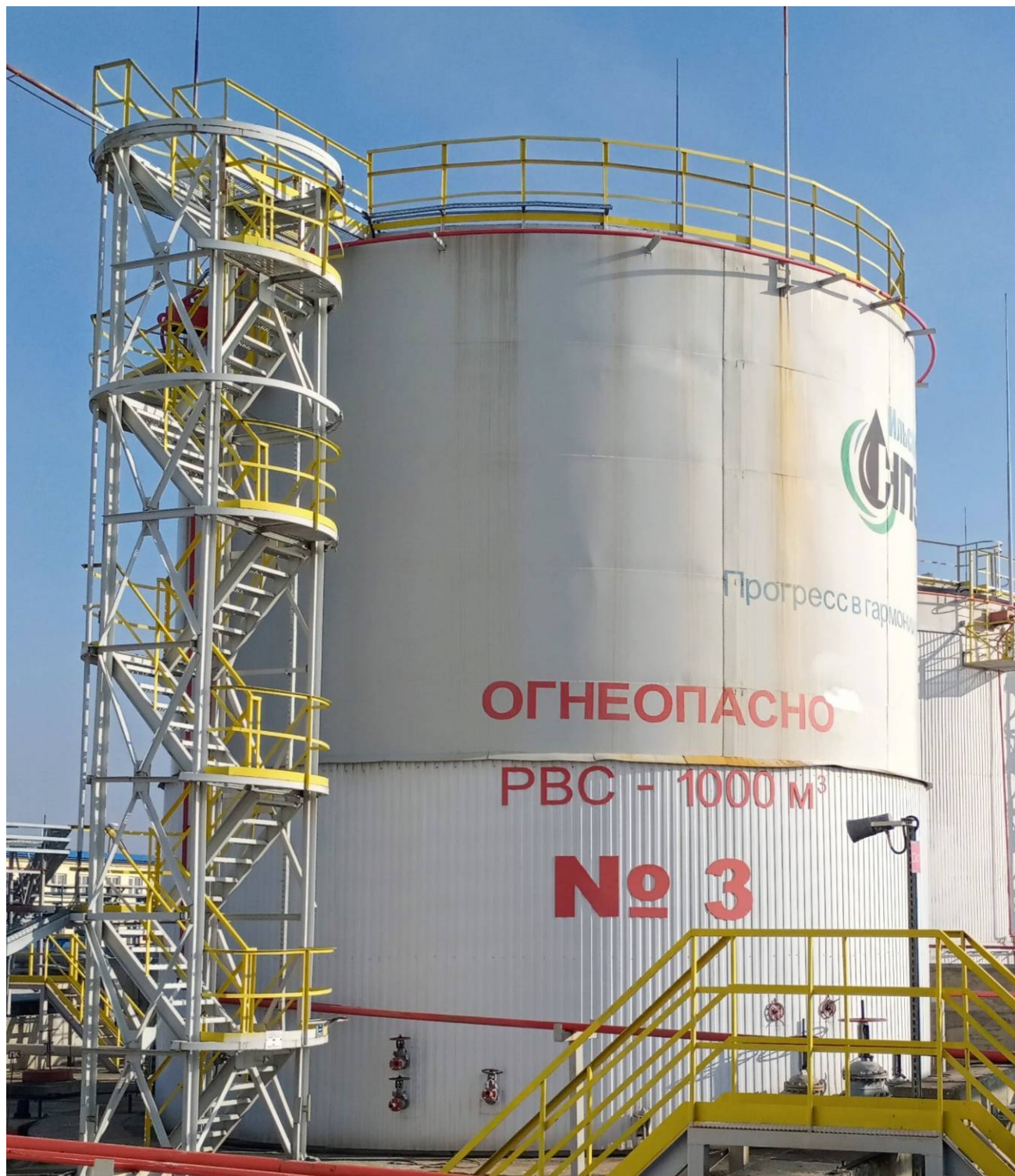
Рисунок 1 - Фотография общего вида резервуара РВС-1000 заводской номер 3.
