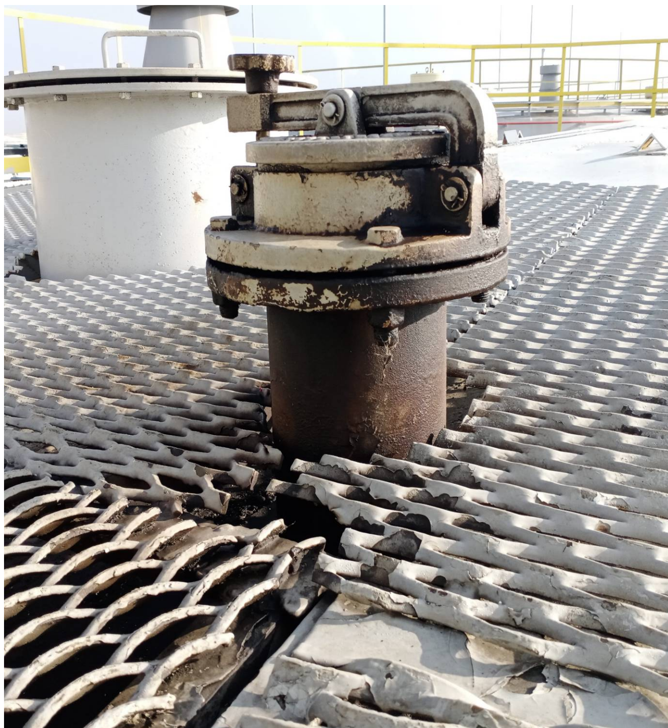
Рисунок 3 - Фотография горловины замерного люка резервуара РВС-1000 заводской номер 3.
