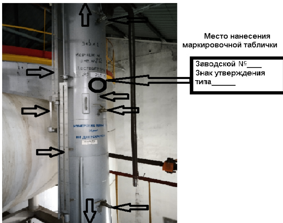
Рисунок 2 – Схема пломбировки мерника М1кл-250, зав.№ 1 от несанкционированного доступа, обозначение места нанесения знака поверки, заводского номера и знака утверждения типа
