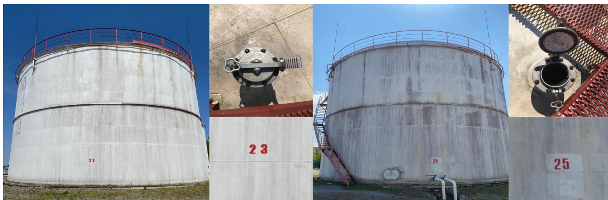
Рисунок 1 – Общий вид резервуаров РВС-3000 (№№ 23, 25) с замерными люками и заводскими номерами
