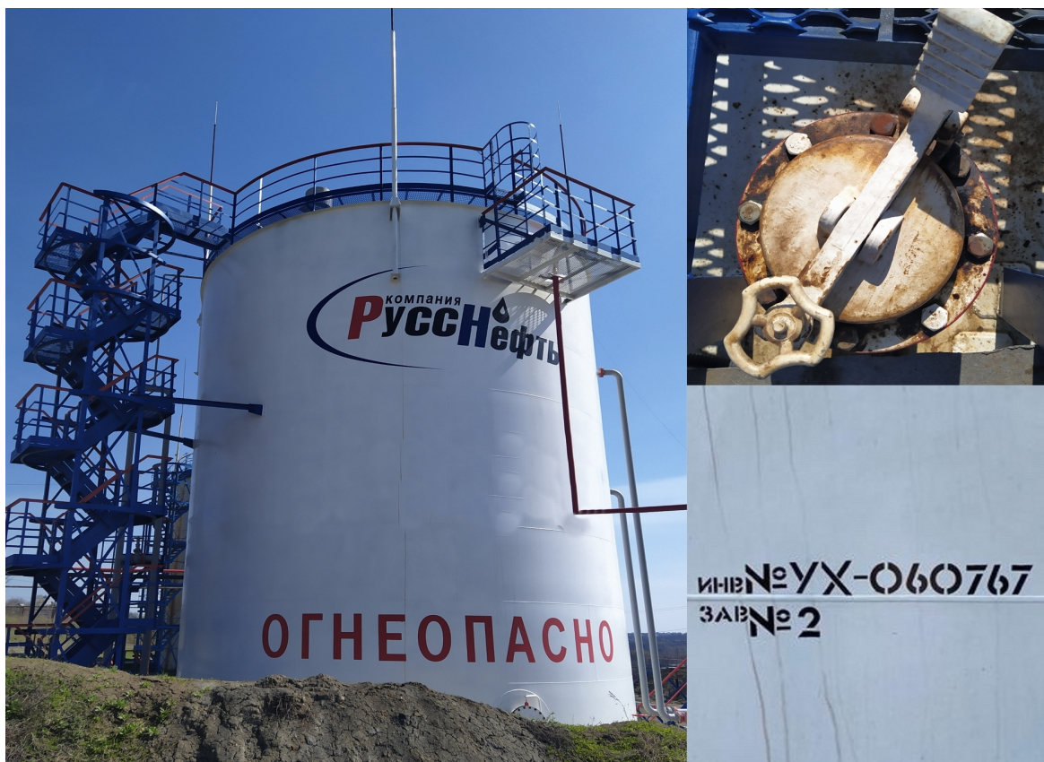
Рисунок 1 – Фотографии общего вида резервуара стального вертикального цилиндрического РВС- 1000, горловины и заводского номера
