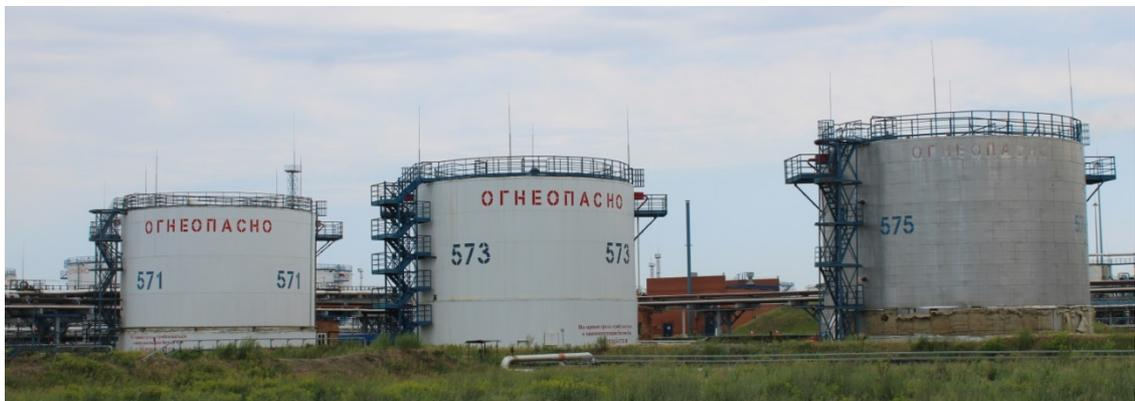
Рисунок 1 - Общий вид резервуаров стальных вертикальных цилиндрических РВС-2000
