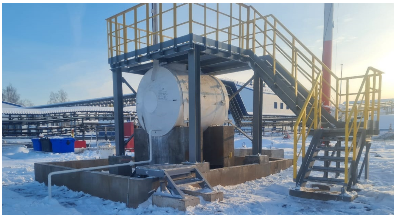
Рисунок 2 – Общий вид резервуара РГС-5
