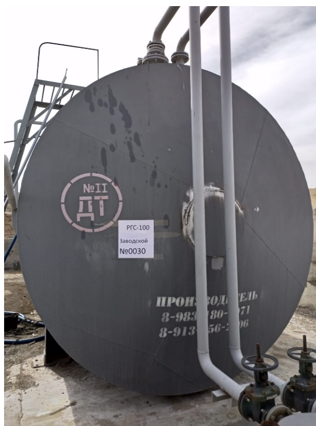
Рисунок 2 – Общий вид резервуара РГС-100 зав.№ 0030
