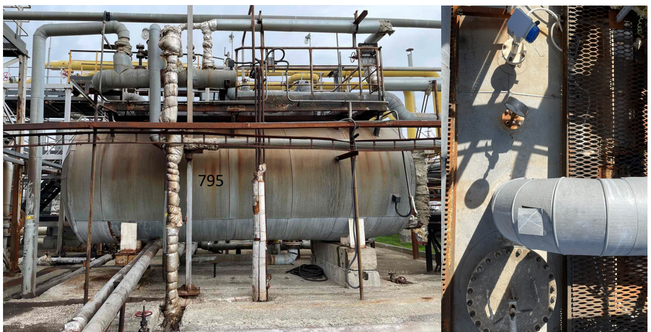
Рисунок 1 – Общий вид резервуара и заливных горловин
