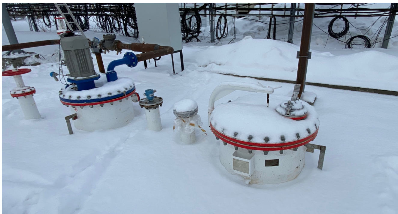
Рисунок 3 – Горловины и измерительный люк резервуара ЕП-20-2400-1-А-СО-У1 зав.№ 158.12.20
