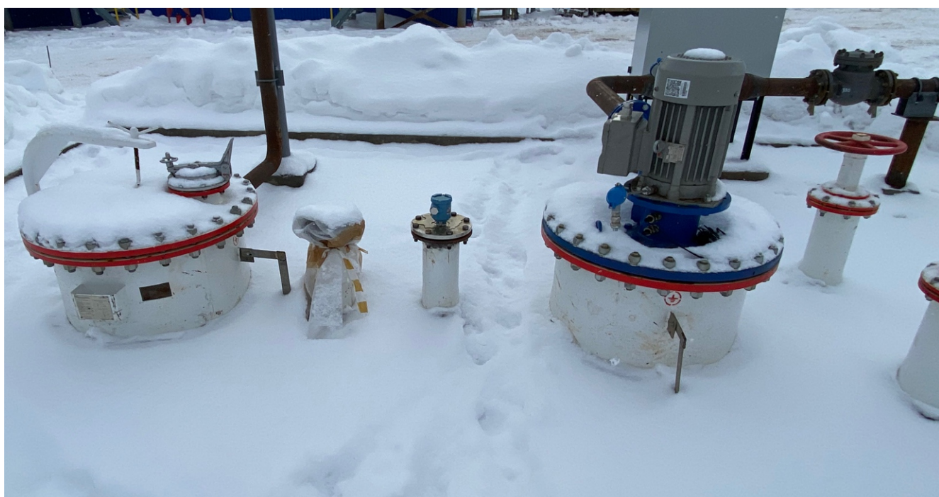
Рисунок 4 – Горловины и измерительный люк резервуара ЕП-20-2400-1-А-СО-У1 зав.№ 160.12.20
