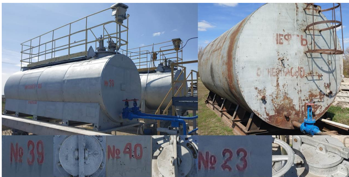
Рисунок 1 – Фотография общего вида резервуаров РГС-20 (№№39, 40), РГС-50 (№23), горловин и заводских номеров
