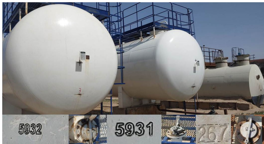
Рисунок 1 – Фотография общего вида резервуаров РГС-100 (№№5931, 5932), РГС-60 (№267), горловин и заводских номеров
