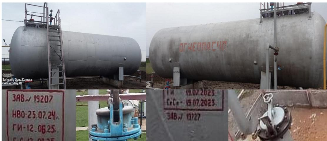
Рисунок 1 – Фотография общего вида резервуаров РГС-50 (№19207), РГС-80 (№19227), горловин и заводских номеров
