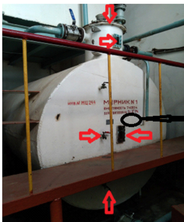
Рисунок 2 – Схема пломбировки мерника МТГ-1, зав. № 1 от несанкционированного доступа, обозначение места нанесения знака поверки, заводского номера и знака утверждения типа
