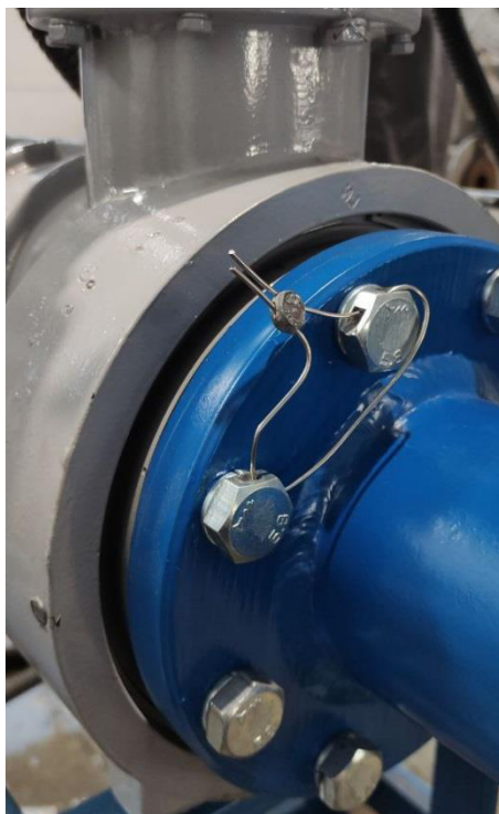
Рисунок 6 – Схема пломбировки фланцев счетчиков жидкости
