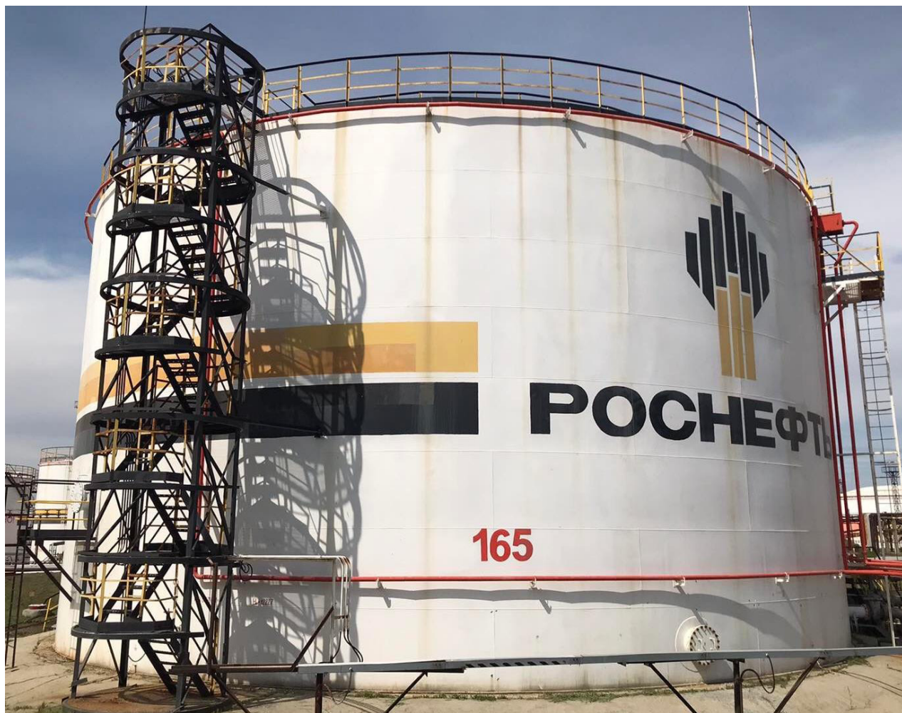
Рисунок 1 – Общий вид резервуара РВСП-5000 №165
