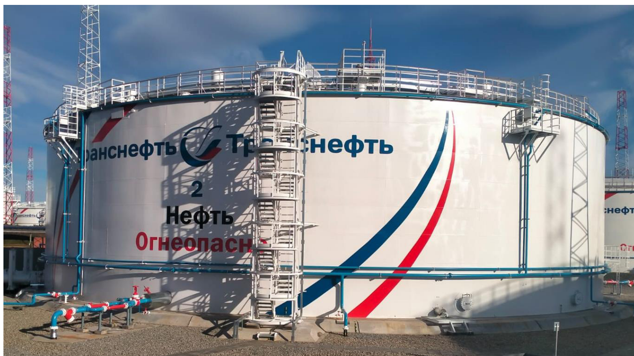
Рисунок 1 – Общий вид резервуара РВСП-20000 №2
