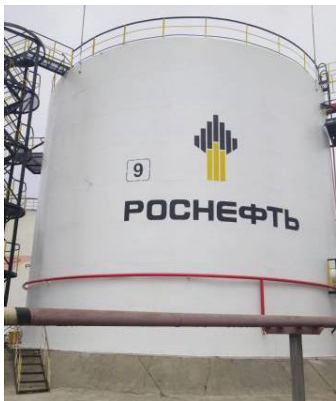
Рисунок 2 – Общий вид резервуара РВСП-2000 №9
