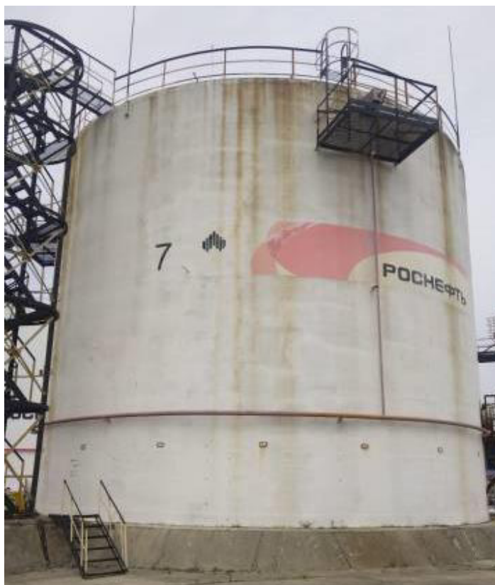
Рисунок 1 – Общий вид резервуара РВСП-2000 №7
