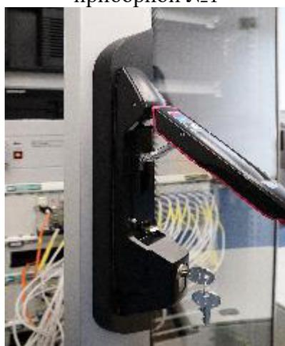
Рисунок 5 – Запирающий механизм стойки
