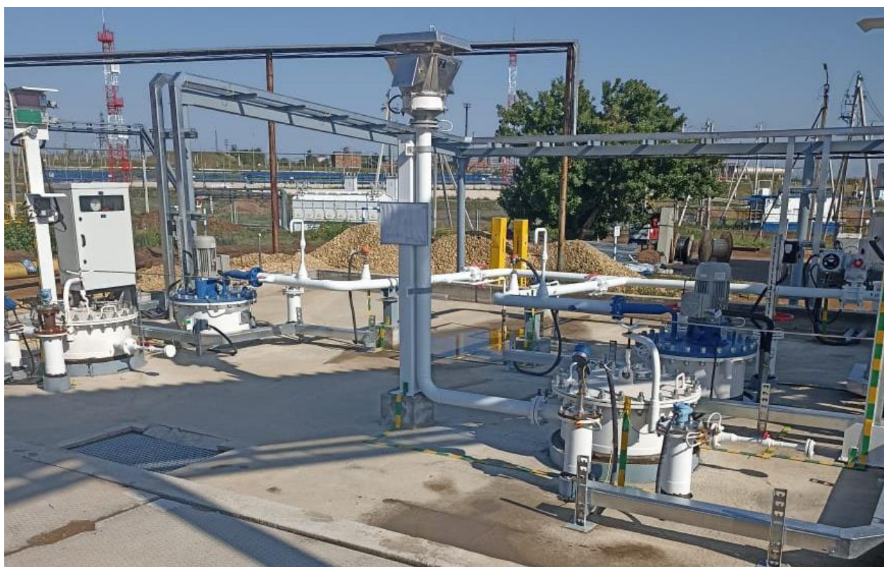
Рисунок 3 – Горловины и измерительные люки резервуаров ЕП-20-2400-2200-А-СО-У1
