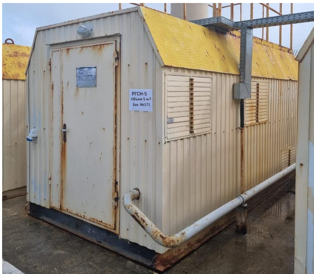
Рисунок 1 – Общий вид резервуара РГСН-5
