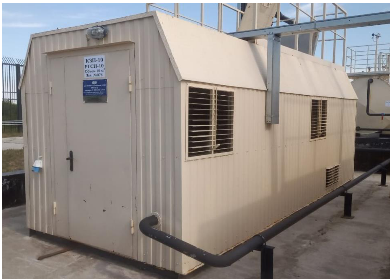
Рисунок 2 – Общий вид резервуара РГСН-10 зав.№ 076
