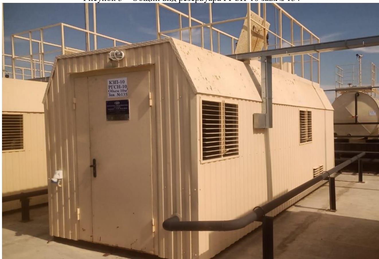
Рисунок 4 – Общий вид резервуара РСН-10 зав.№ 135
