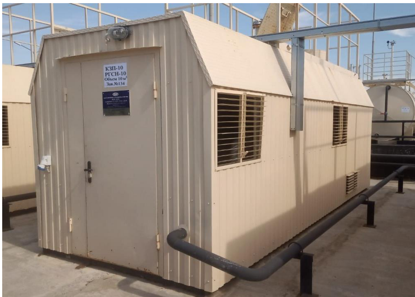
Рисунок 3 – Общий вид резервуара РСН-10 зав.№ 134
