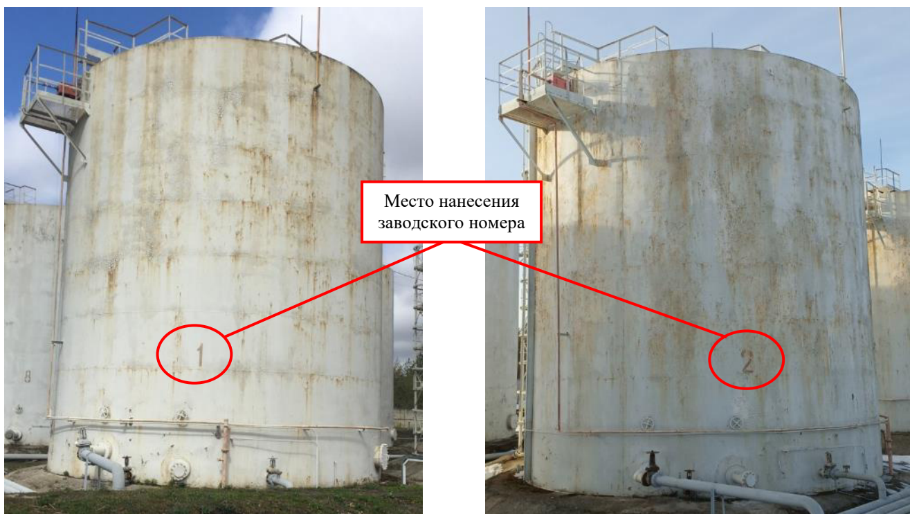
Рисунок 1 – Общий вид резервуаров стальных вертикальных цилиндрических РВС-1000 зав.№ 1, зав.№ 2
