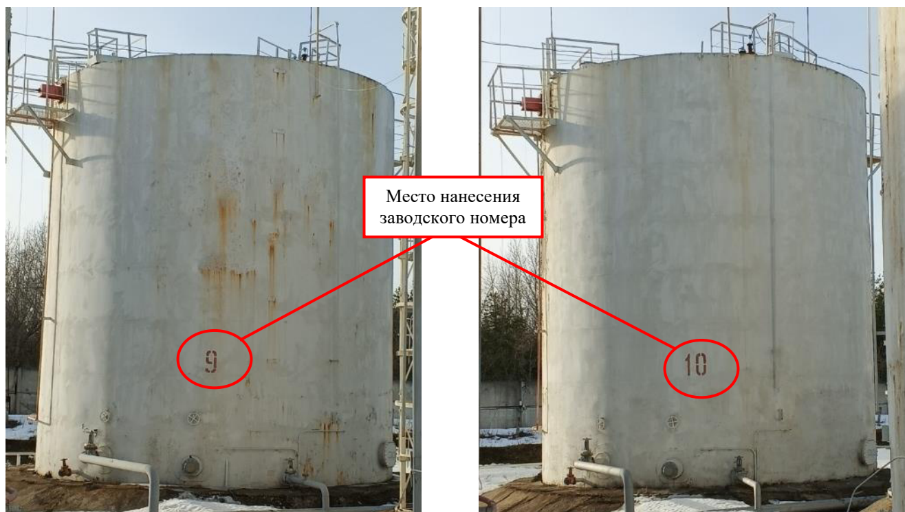
Рисунок 5 – Общий вид резервуара стального вертикального цилиндрического РВС-1000 зав.№ 9, зав.№ 10
