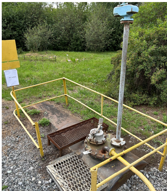
Рисунок 2 – Общий вид заливной горловины
