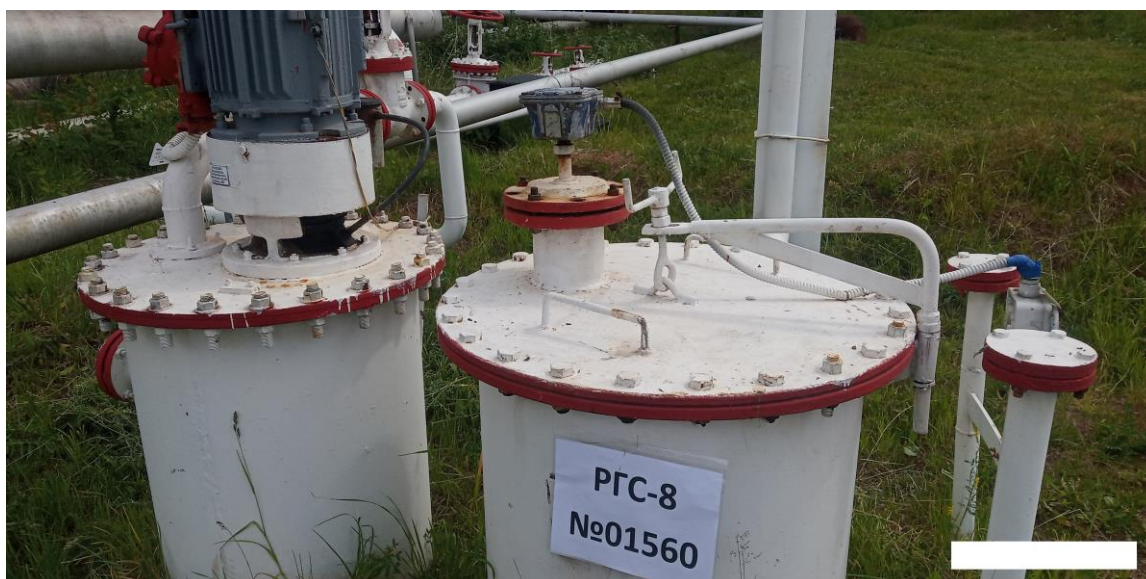
Рисунок 2 – Общий вид заливной горловины
