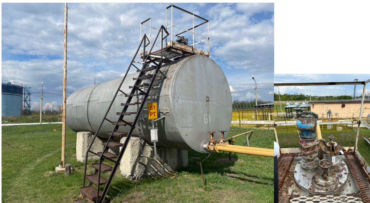
Рисунок 1 – Общий вид резервуара и замерного люка РГС-50
