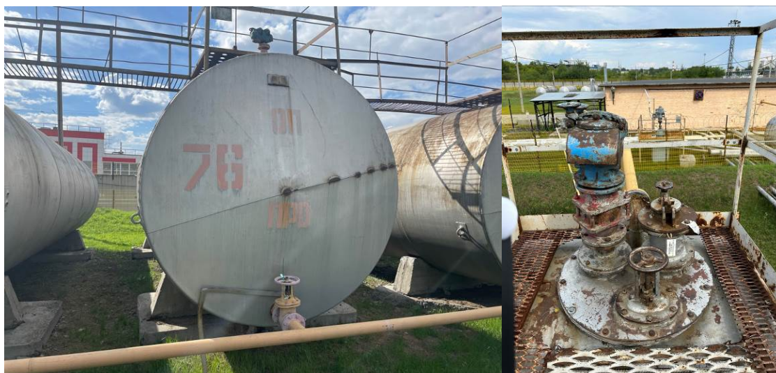
Рисунок 3 – Общий вид резервуара и замерного люка РГС-60 зав.№ 76
