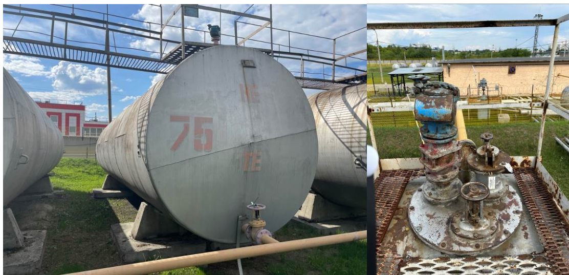
Рисунок 2 – Общий вид резервуара и замерного люка РГС-60 зав.№ 75
