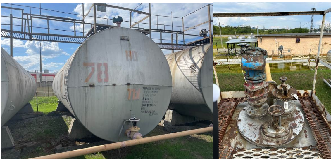
Рисунок 5 – Общий вид резервуара и замерного люка РГС-60 зав.№ 78
