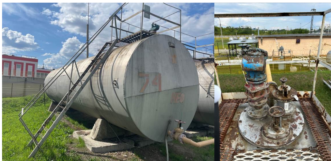
Рисунок 1 – Общий вид резервуара и замерного люка РГС-60 зав.№ 74
