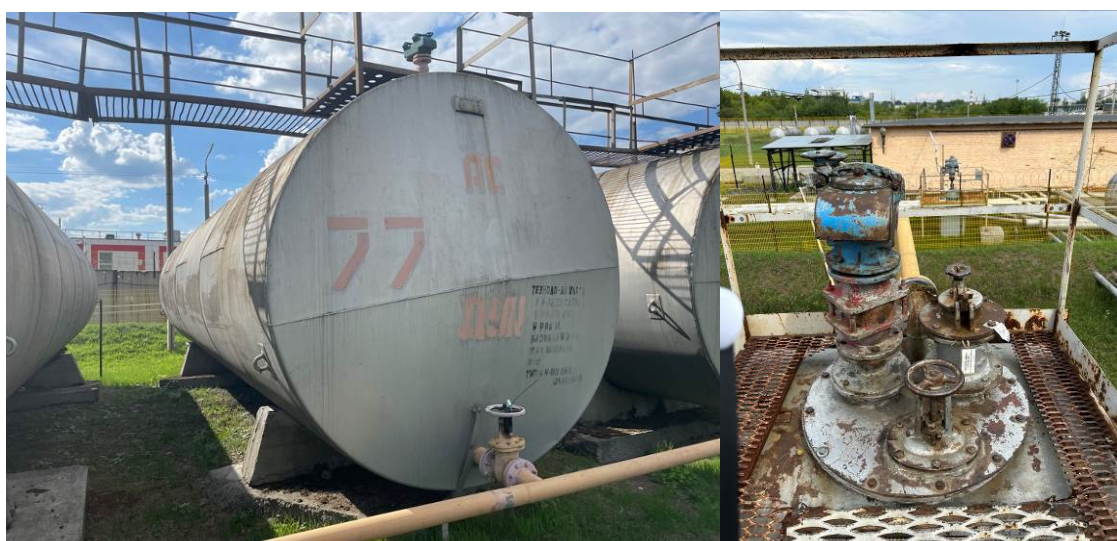
Рисунок 4 – Общий вид резервуара и замерного люка РГС-60 зав.№ 77
