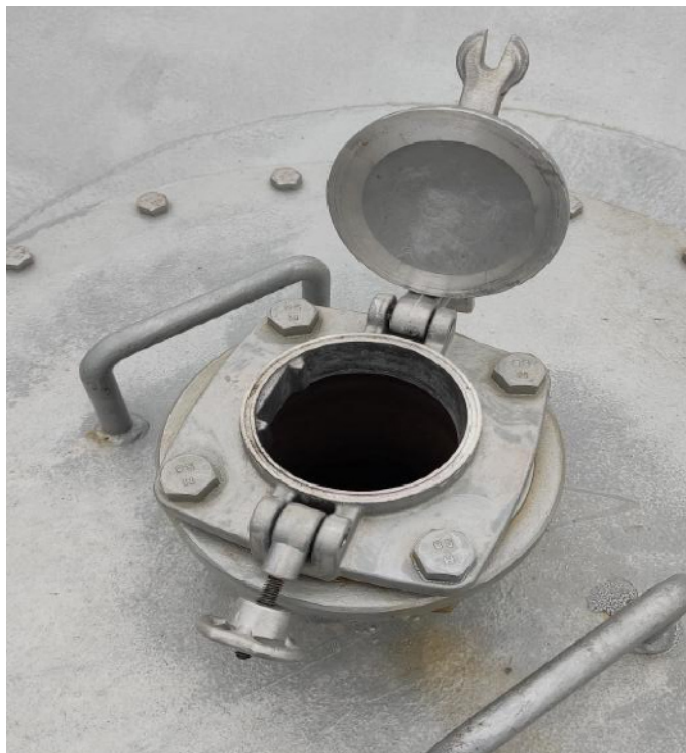
Рисунок 3 – Фотография горловины замерного люка резервуара РВСП-1000 заводской номер 295.
