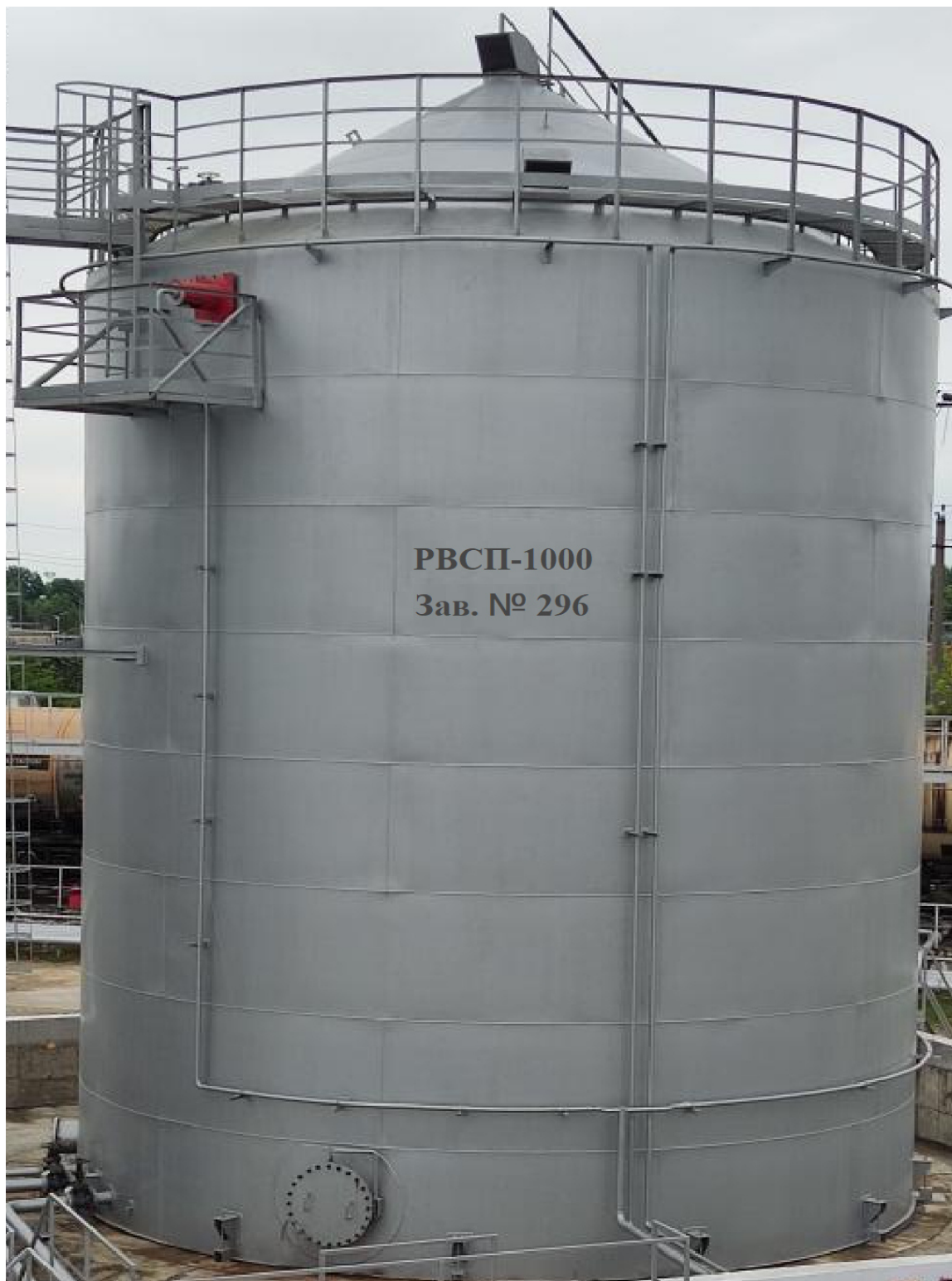
Рисунок 2 - Фотография общего вида резервуара РВСП-1000 заводской номер 296.
