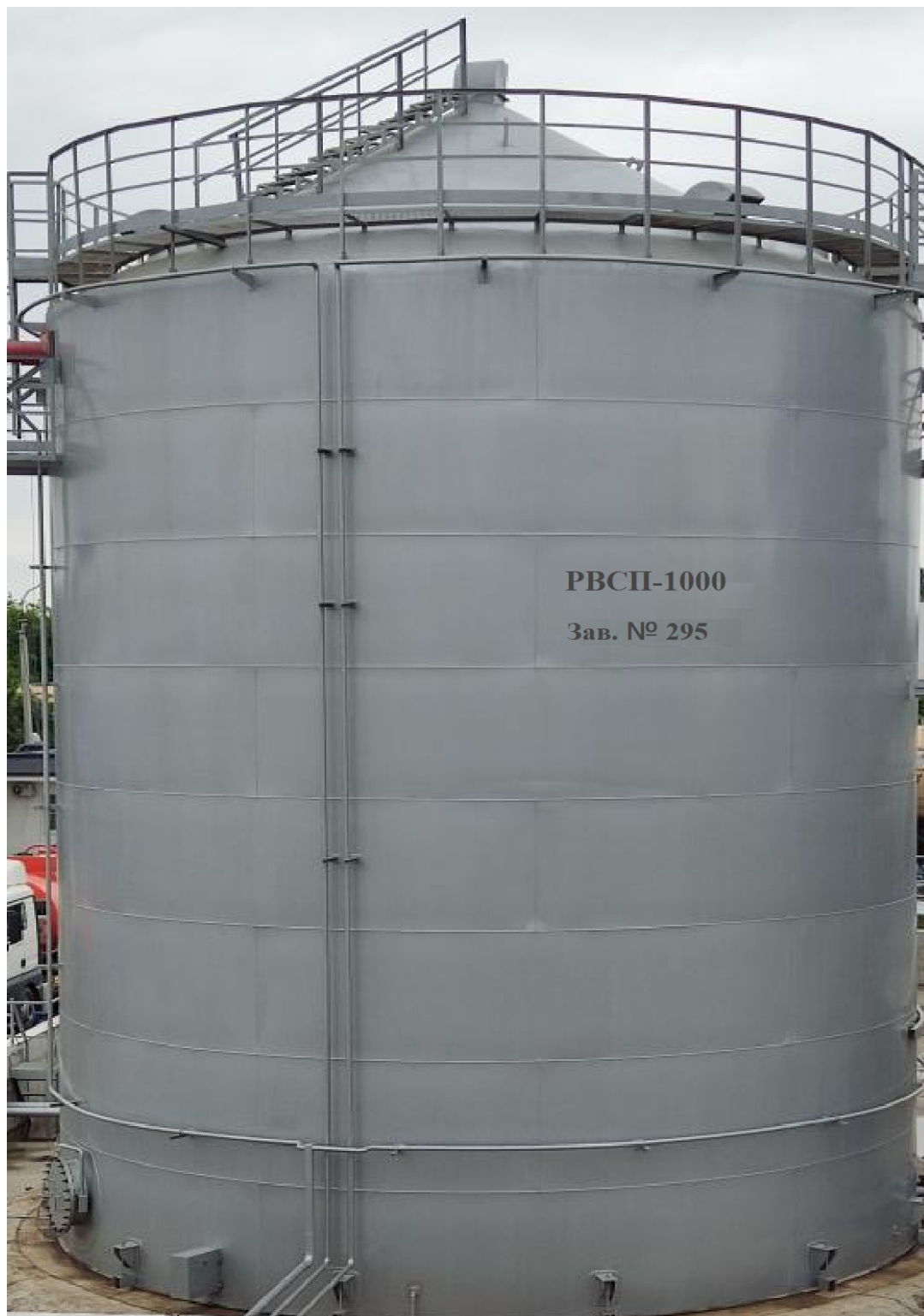
Рисунок 1 - Фотография общего вида резервуара РВСП-1000 заводской номер 295.
