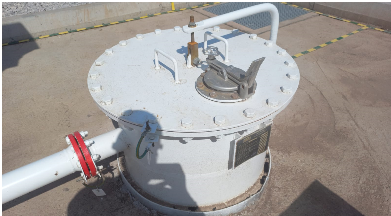
Рисунок 4 – Горловина и измерительный люк резервуара ЕП-40-2400-600-А-СО-У1 зав.№ 7212
