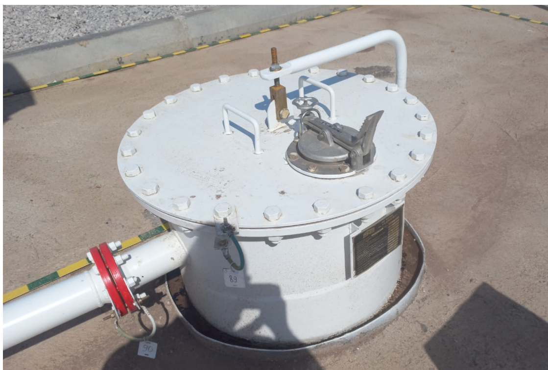
Рисунок 3 – Горловина и измерительный люк резервуара ЕП-40-2400-600-А-СО-У1 зав.№ 7211
