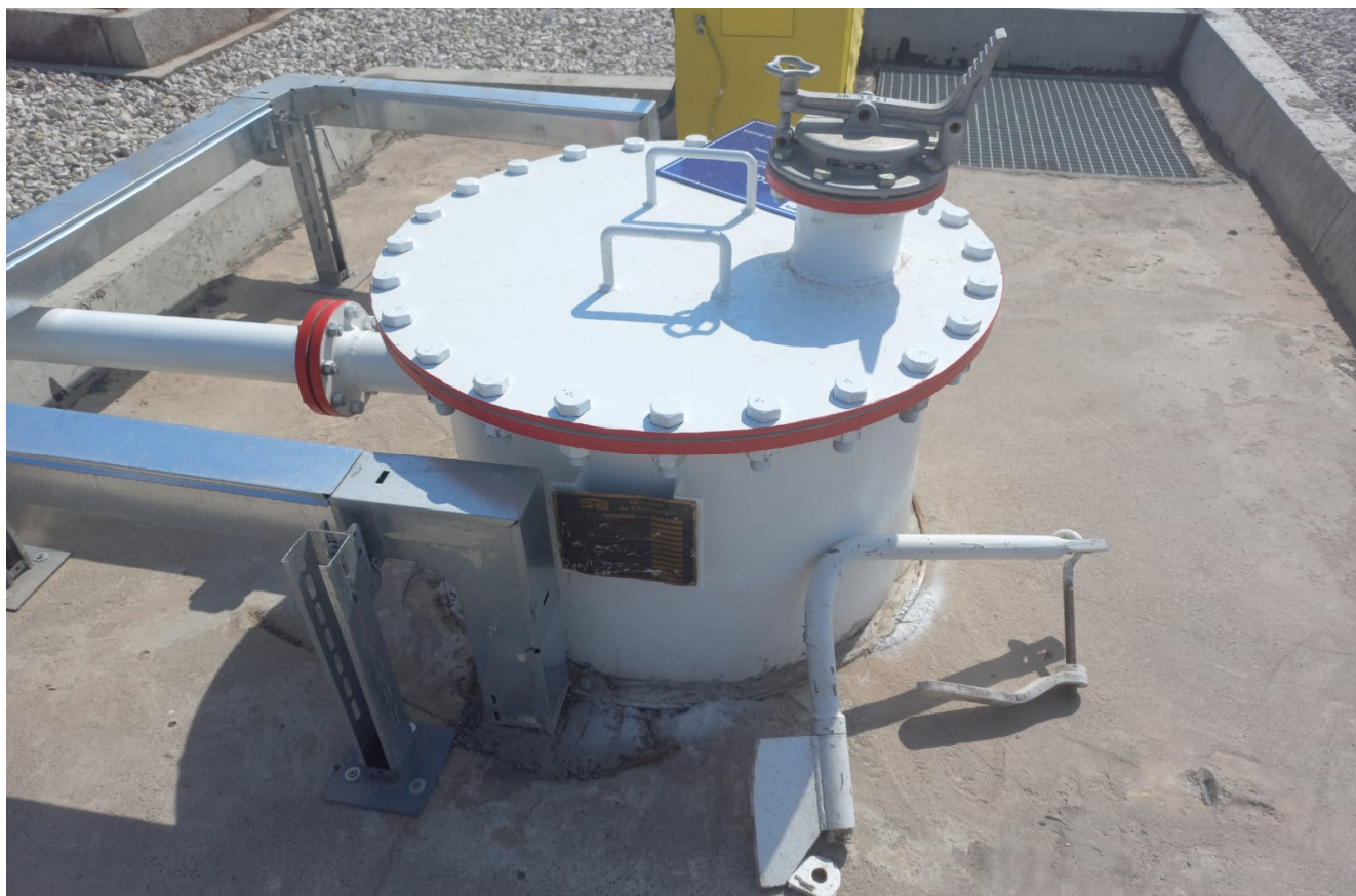
Рисунок 3 – Горловина и измерительный люк резервуара ЕП-40-2400-2-А-СО-У1 зав.№ 7210
