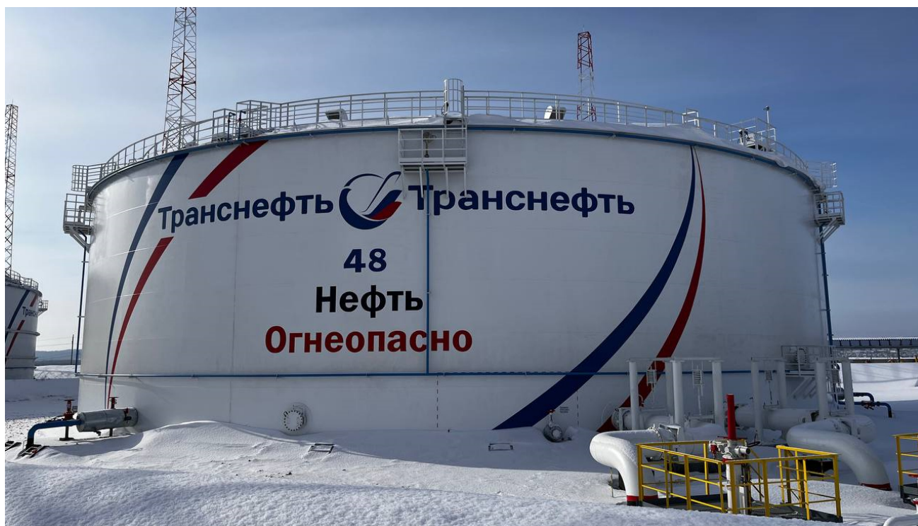
Рисунок 1 – Общий вид резервуара РВСП-20000 зав.№48
