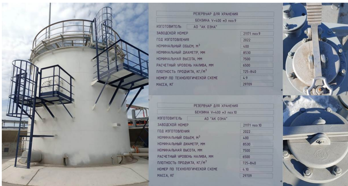
Рисунок 1 – Фотографии общего вида резервуаров вертикальных цилиндрических стальных с понтоном РВСп-400, горловин и заводских номеров
