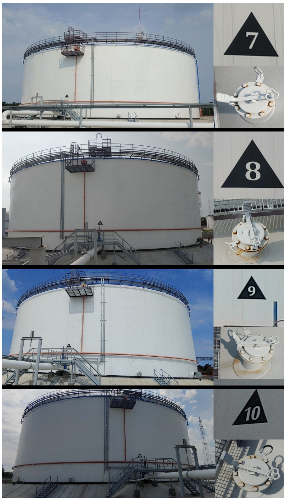
Рисунок 1 – Фотографии общего вида резервуаров стальных вертикальных цилиндрических РВС-10000, горловин и заводских номеров
