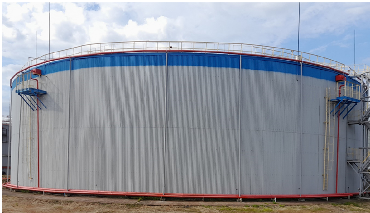
Рисунок 1 – Общий вид резервуара
