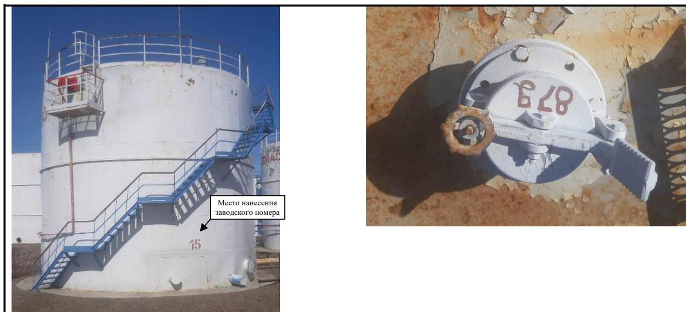
Рисунок 2 – Общий вид резервуара РВС-700 (№15) с замерным люком
