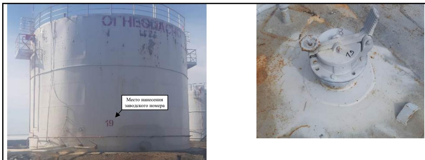
Рисунок 3 – Общий вид резервуара РВС-1000 (№19) с замерным люком
