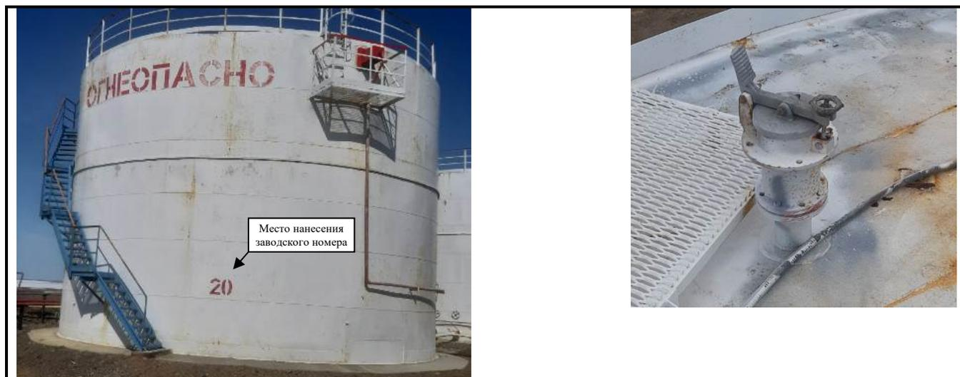
Рисунок 4 – Общий вид резервуара РВС-1000 (№20) с замерным люком
