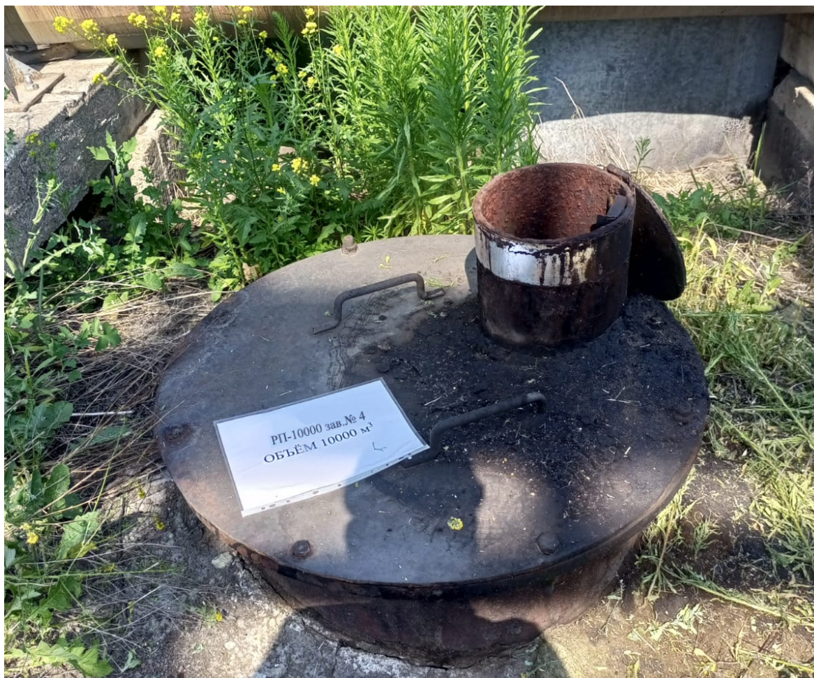
Рисунок 2 – Горловина резервуара РП-10000 № 4 Пломбирование резервуара РП-10000 не предусмотрено.
