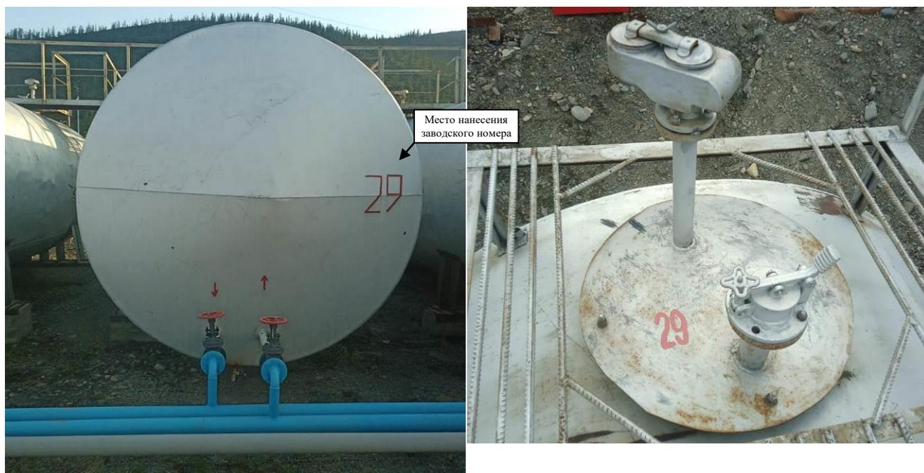
Рисунок 1 – Общий вид резервуара РГС-50 (заводской номер 29) с замерным люком
