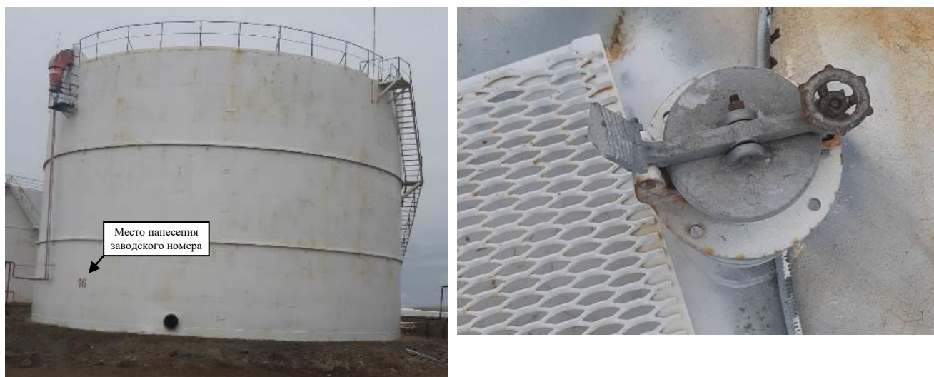
Рисунок 4 – Общий вид резервуара РВС-3000 (заводской номер 16) с замерным люком
