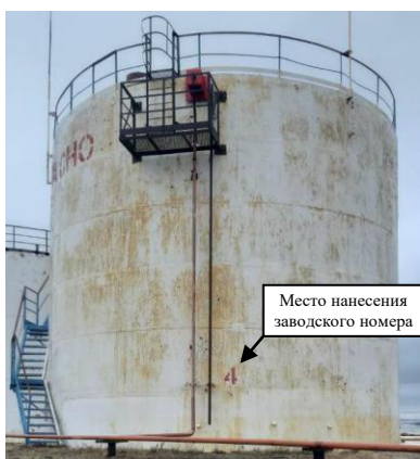
Рисунок 1 – Общий вид резервуара РВС-700 (заводской номер 4) с замерным люком
