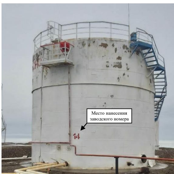
Рисунок 2 – Общий вид резервуара РВС-700 (заводской номер 14) с замерным люком
