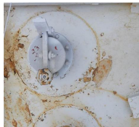
Рисунок 1 – Общий вид резервуара РВС-700 (заводской номер 4) с замерным люком
