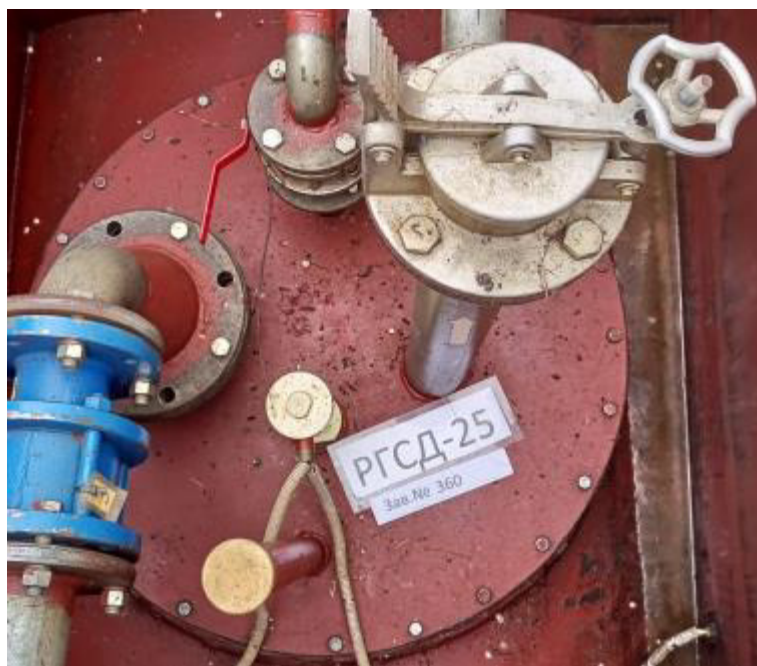
Рисунок 2 – Горловина и измерительный люк резервуара РГСД-25 зав.№360 Пломбирование резервуара РГСД-25 не предусмотрено.
