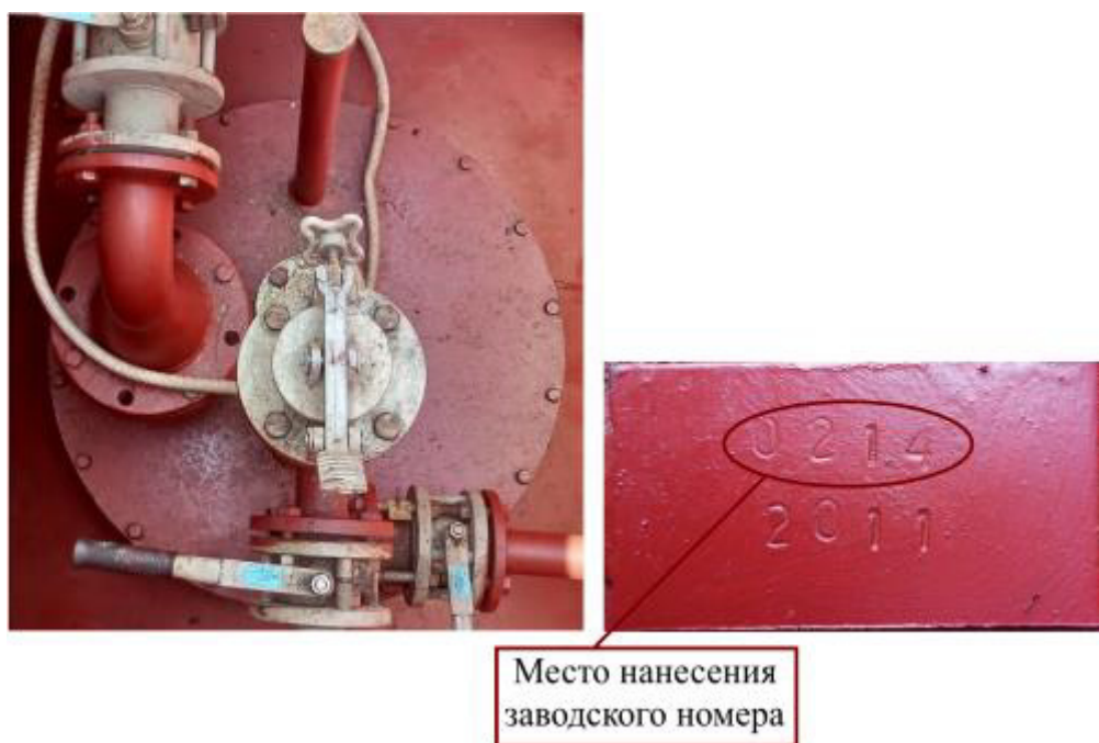
Рисунок 9 – Горловина и измерительный люк резервуара РГП 25-1-2(0,85)-О-У зав.№ 0214
