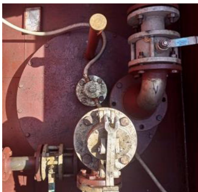
Рисунок 4 – Горловина и измерительный люк резервуара РГП 25-1-2(0,85)-О-У зав.№ 0206
