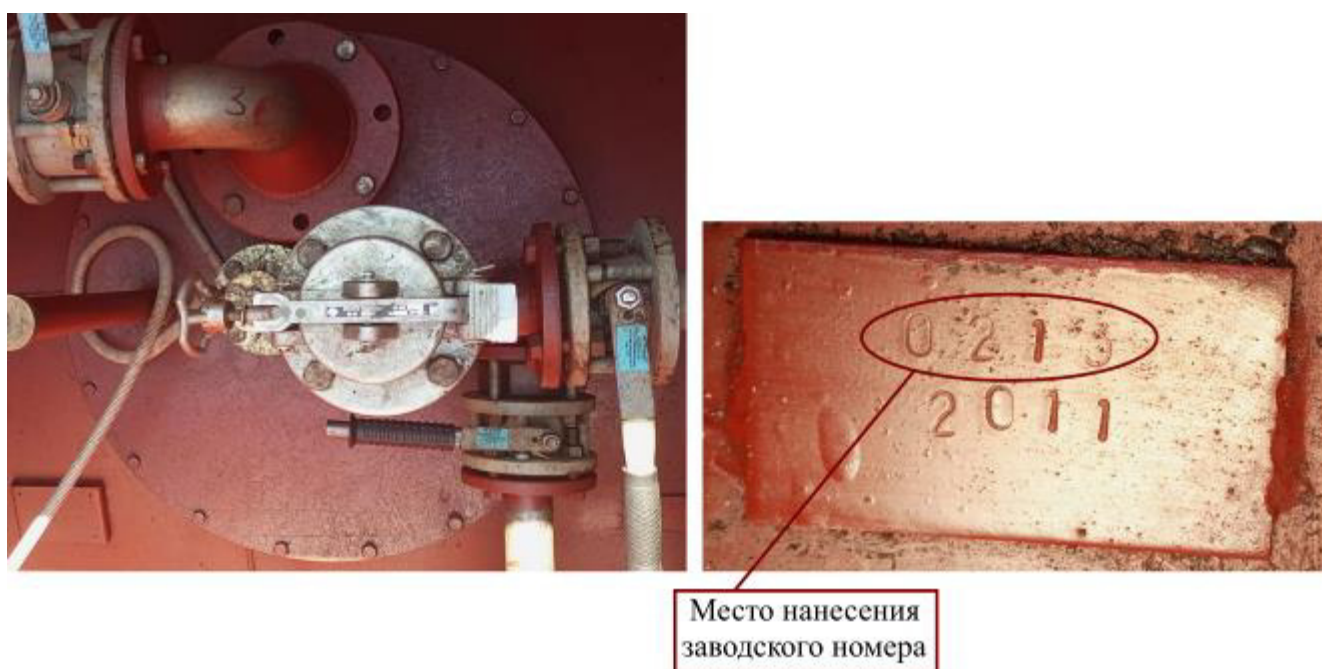
Рисунок 8 – Горловина и измерительный люк резервуара РГП 25-1-2(0,85)-О-У зав.№ 0213
