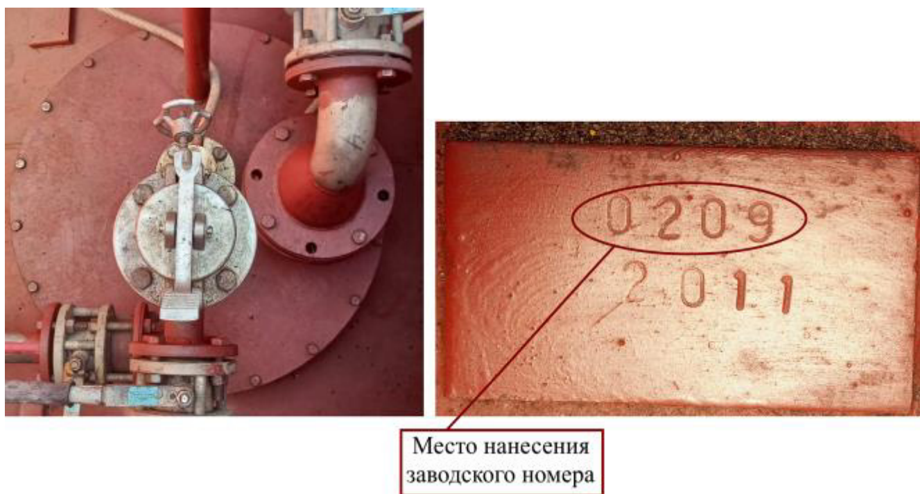
Рисунок 5 – Горловина и измерительный люк резервуара РГП 25-1-2(0,85)-О-У зав.№ 0209
