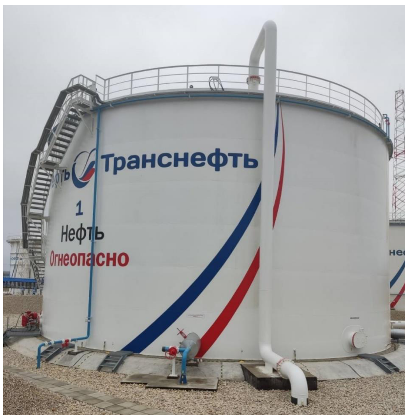
Рисунок 1 – Общий вид резервуара РВСП-5000
