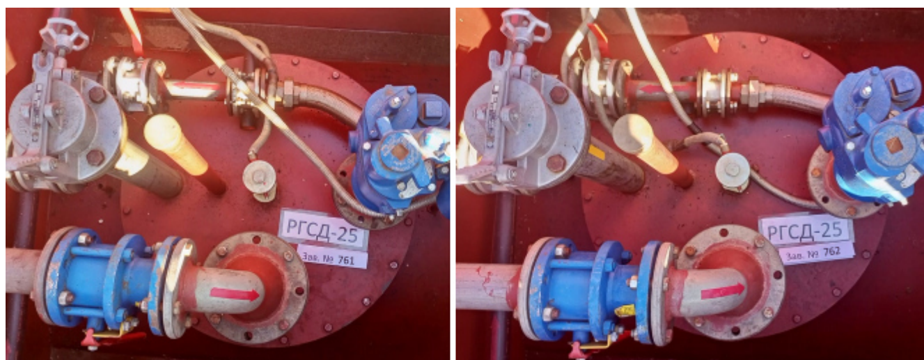
Рисунок 4 – Горловины и измерительные люки резервуаров РГСД-25 зав.№№ 761, 762
