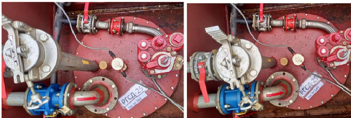
Рисунок 5 – Горловины и измерительные люки резервуаров РГСД-25 зав.№№ 343, 344
