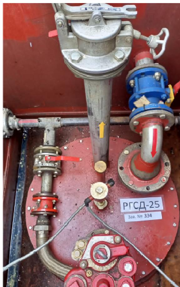
Рисунок 2 – Горловины и измерительные люки резервуаров РГСД-25 зав.№№ 333, 334
