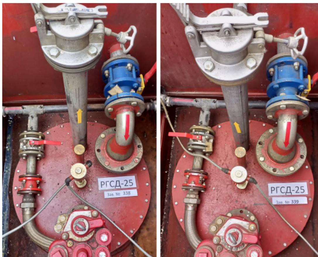
Рисунок 3 – Горловины и измерительные люки резервуаров РГСД-25 зав.№№ 338, 339
