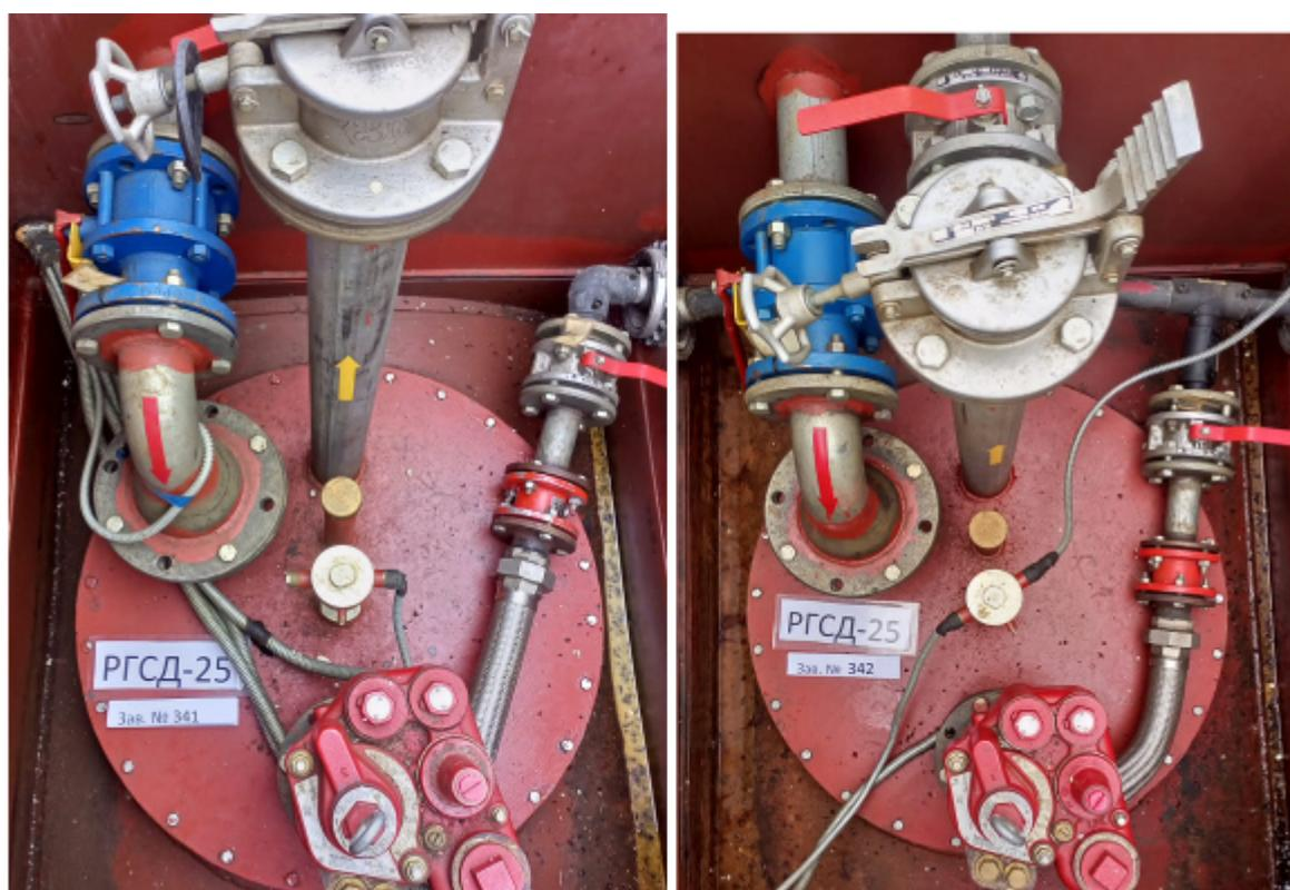
Рисунок 4 – Горловины и измерительные люки резервуаров РГСД-25 зав.№№ 341, 342
