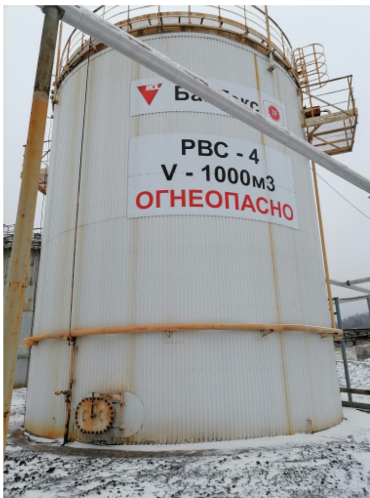
Рисунок 1 – Общий вид резервуара PBC-1000
