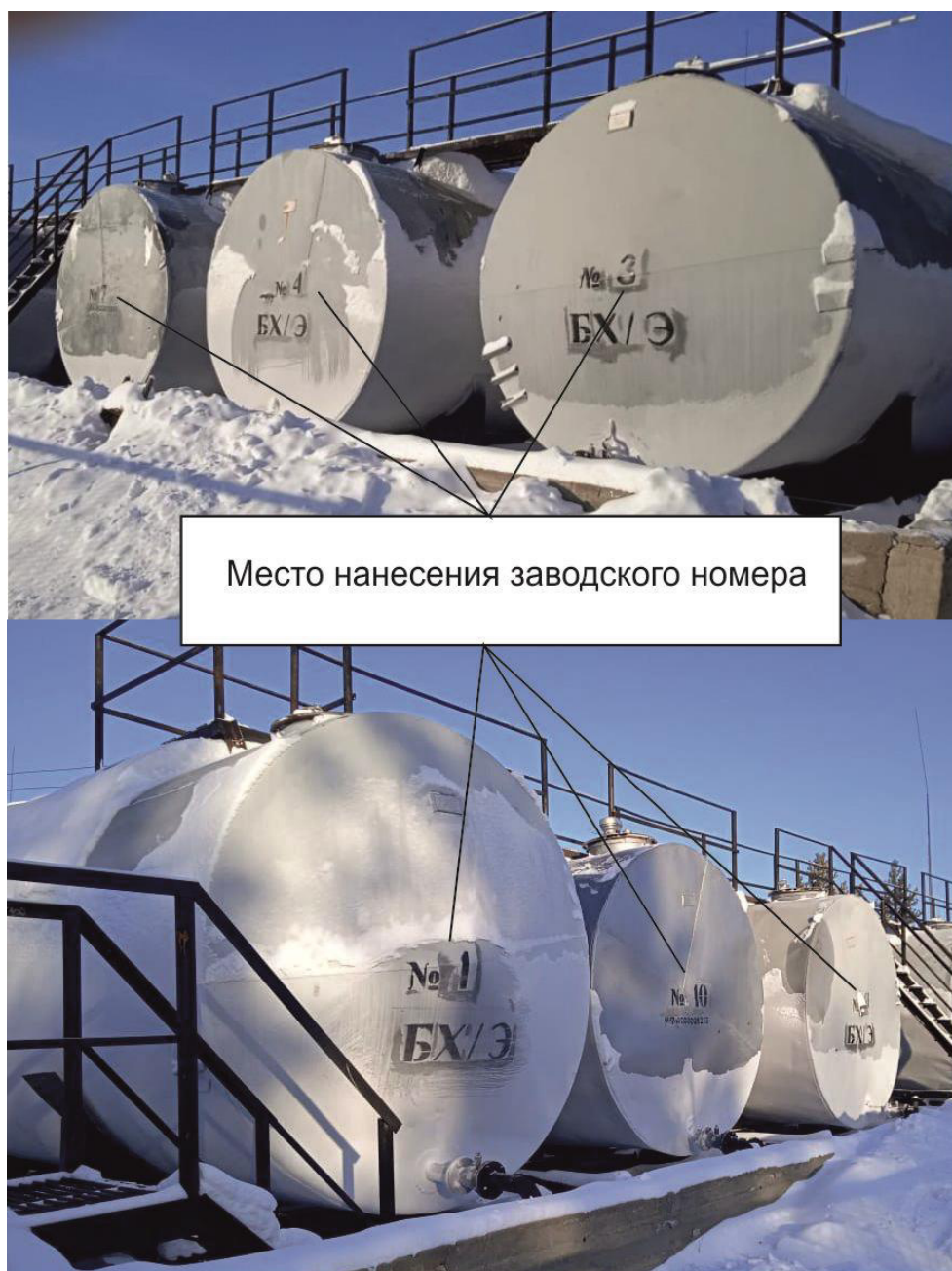
Рисунок 1 – Общий вид резервуаров горизонтальных стальных цилиндрических РГС с указанием места нанесения заводских номеров
