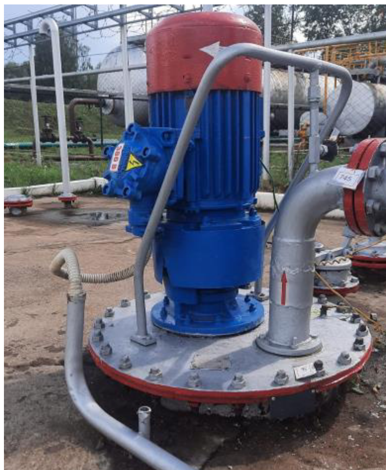
Рисунок 2 – Горловина и измерительный люк резервуара ЕП-10-2000-1-2
