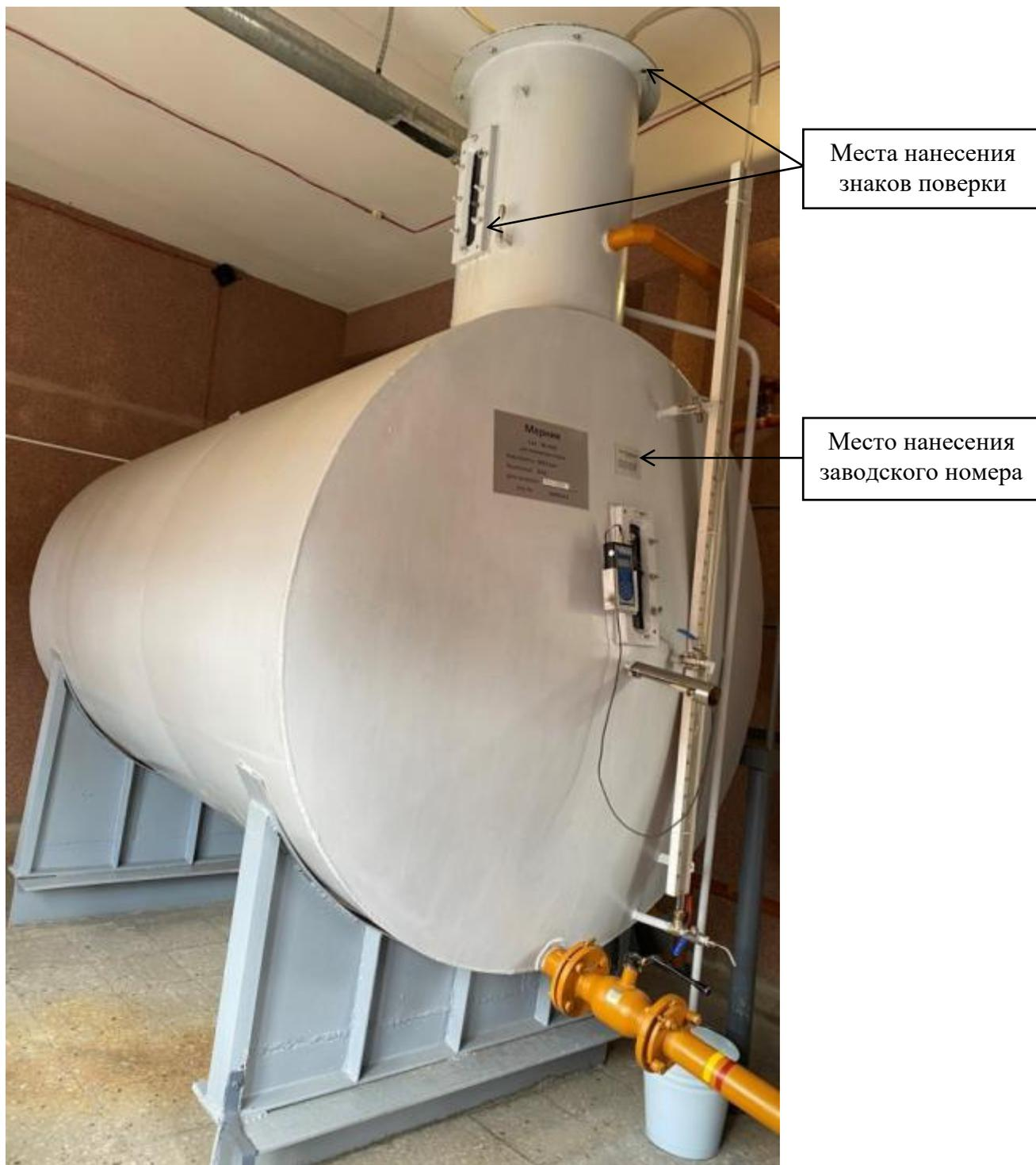
Рисунок 1 – Общий вид мерника стационарного металлического технического 1-го класса МСМТ-3 № 1929 с указанием мест пломбировки и места нанесения заводского номера
