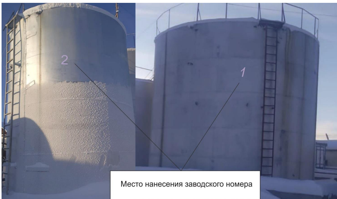
Рисунок 1 – Общий вид резервуаров вертикальных стальных цилиндрических PVC с указанием места нанесения заводских номеров
