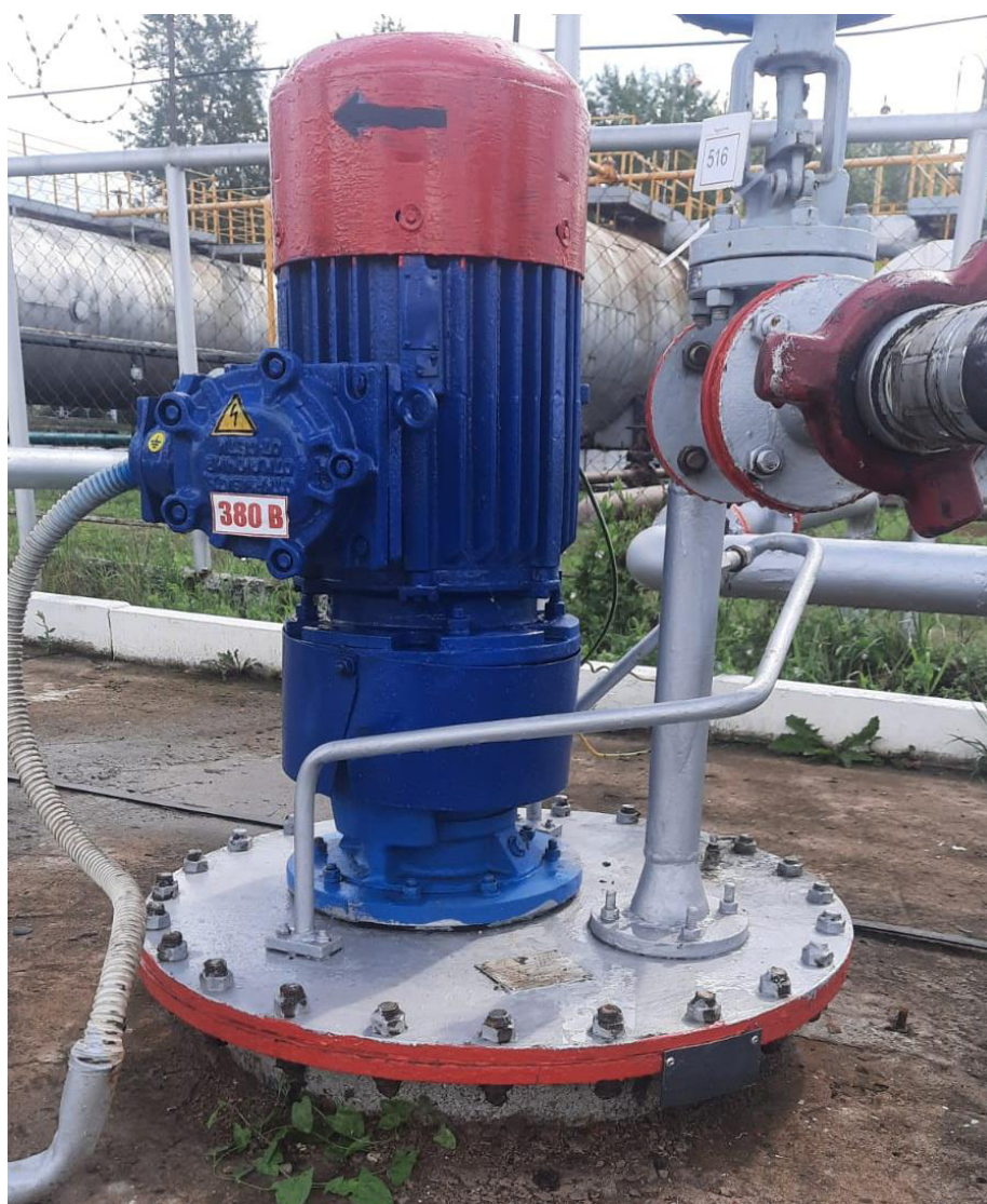
Рисунок 2 – Горловина резервуара ЕП-50-2400-1
