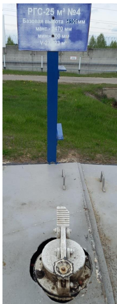
Рисунок 3 – Фотография горловины и заводского номера резервуара стального горизонтального цилиндрического РГС модификации РГС-25, заводской номер 4
