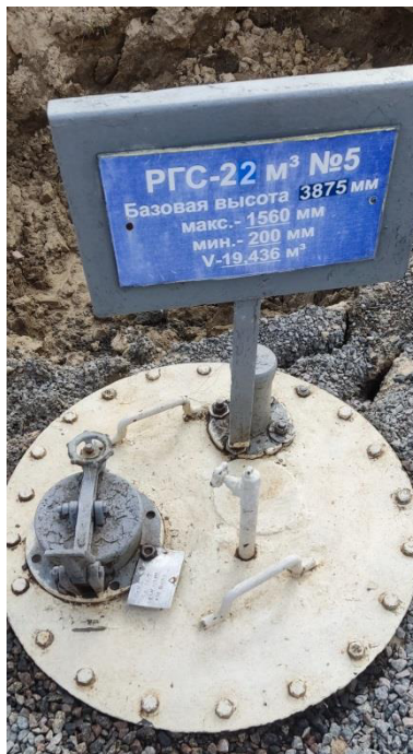
Рисунок 2 – Фотография горловины и заводского номера резервуара стального горизонтального цилиндрического РГС модификации РГС-22, заводской номер 5
